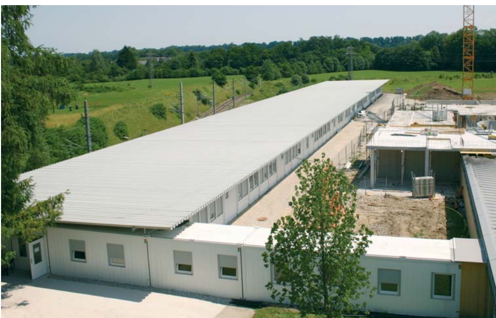
Временное здание рядом со стройкой
