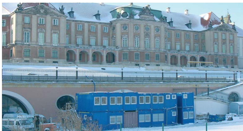
Варшава - ремонт королевского дворца
