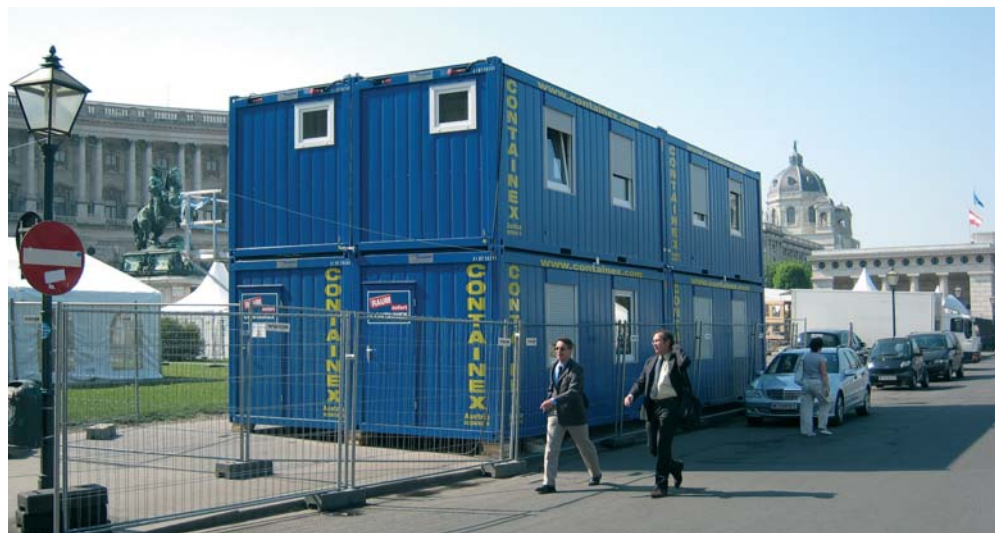
Вена – Стройка в центре Вены / вблизи от дворца Хофбург
