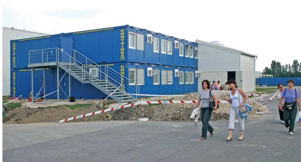
Секешфейвар - расширение здания
