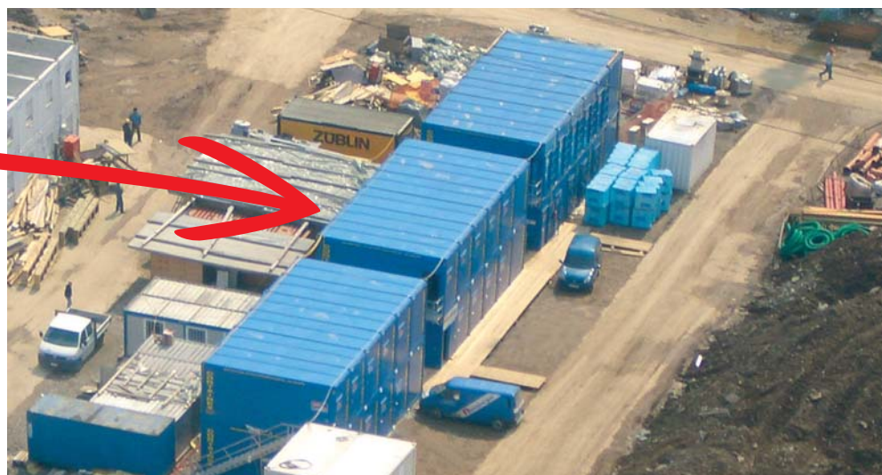
Милан – строительный офис
